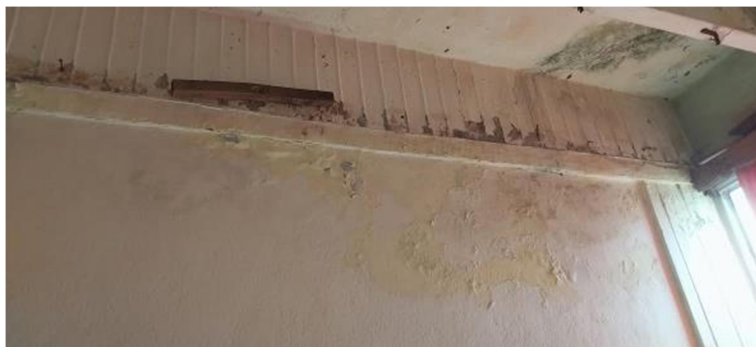
Figure 2 : Moisissures et humidité sur les murs et les plafonds / Eaux usées sur le couloir du rez-de-chaussée Source : Cour des Comptes
